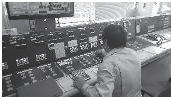
写真1 ダムの運転管理状況
