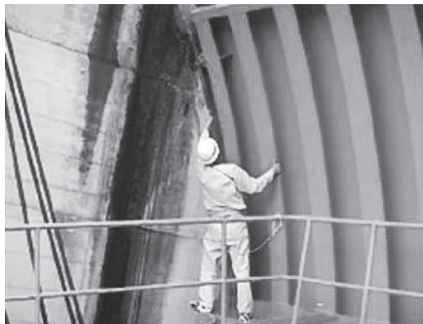
写真2 施設の点検状況
